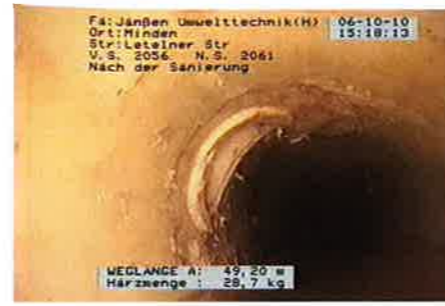
Dieselben Stutzen in Minden nach der Sanierung. | Fotos: Janßen Umwelttechnik
