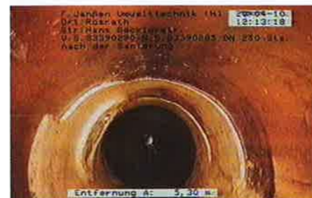
Derselbe Stutzen nach der Sanierung.
