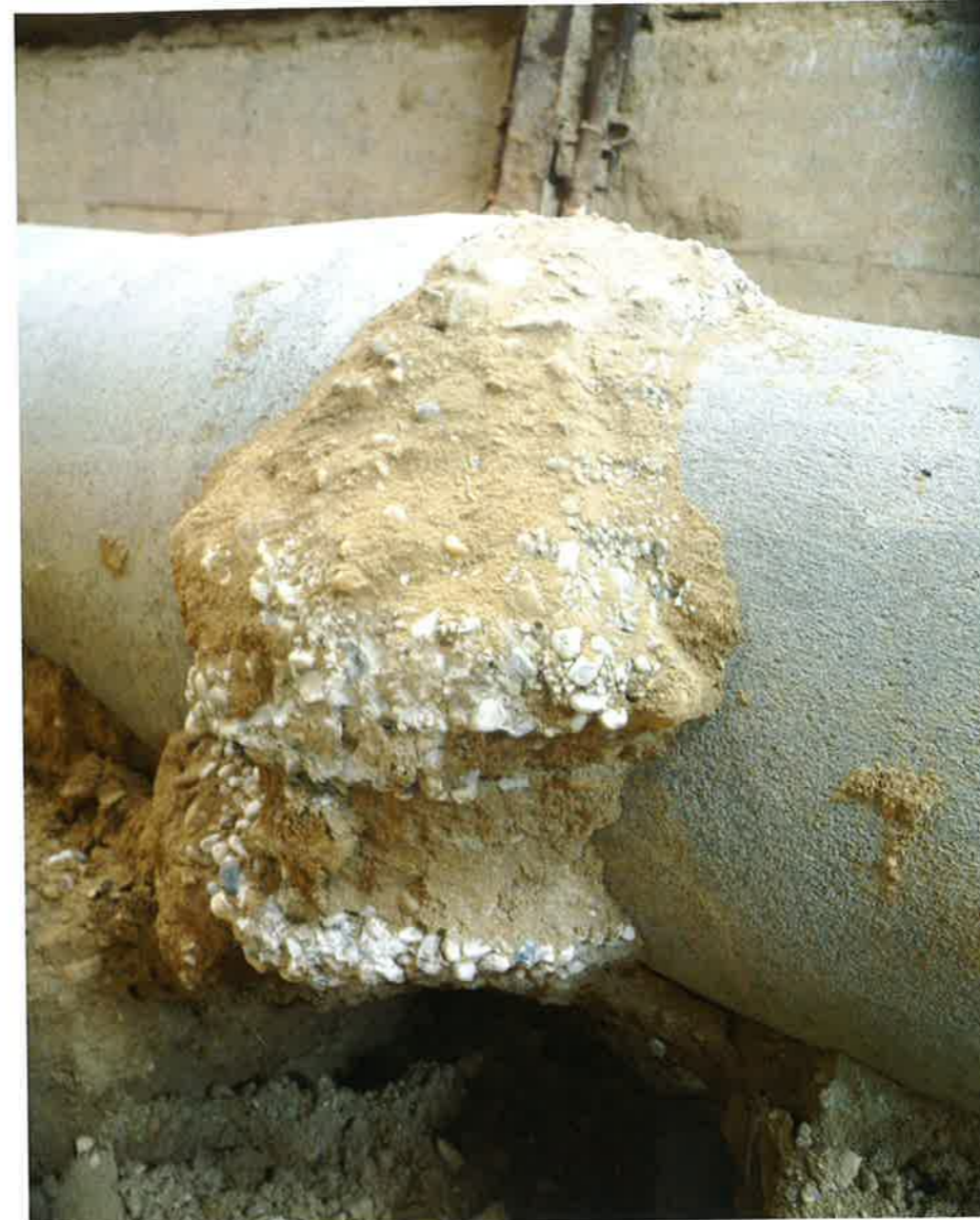
Verfüllung von Bodenhohlräumen
