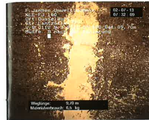
Sanierte Rohrverbindung innen
