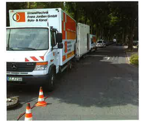
Baustelle Lantzallee Düsseldorf
