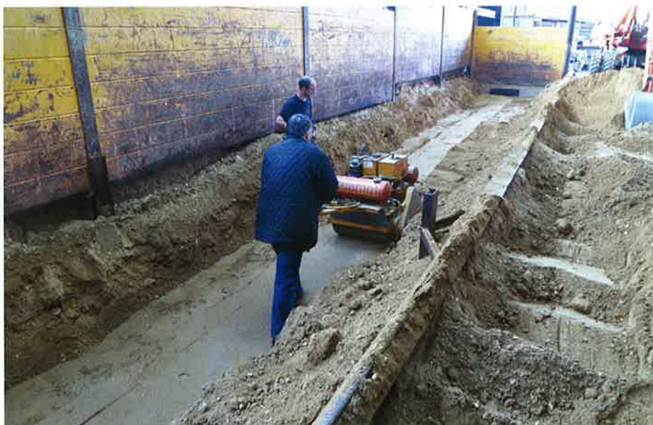
Nach dem Einbau der Rohre wurde der Boden verdichtet.
