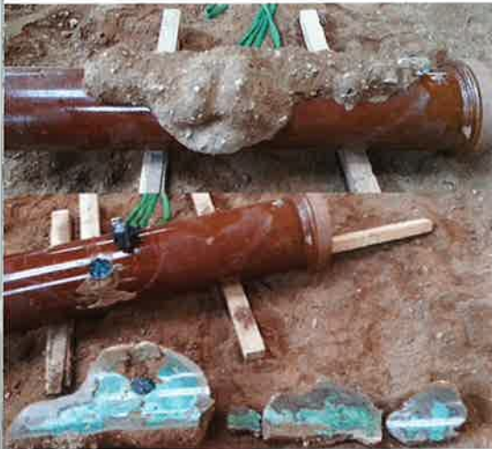
Injektionskörper Rohr 1 (kreisrundes Loch) vor und nach der Abtrennung.
