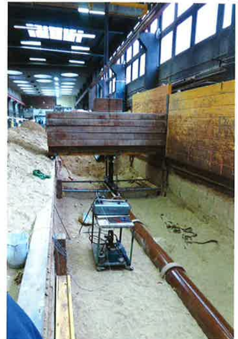
Scheiteldruckprüfung im freigelegten Rohrgraben.
