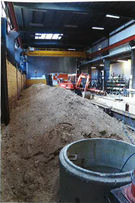
Fertig gestellter Teststand, im Hintergrund steht das Sanierungsfahrzeug.
