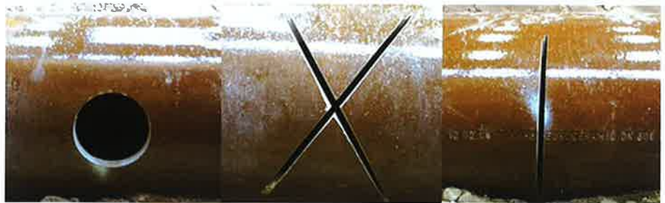
Mit diesen Schäden wurden die Rohre 1 bis 3 (von links) vor dem Einbau in versehen.
