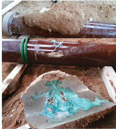
Injektionskörper Rohr 3 (Kreuzriss) vor und nach der Abtrennung.
