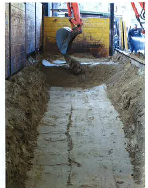
In einem weiteren Schritt wurde der Teststand aufgefüllt.
