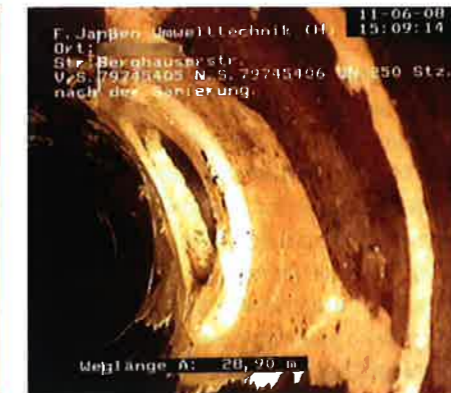
Abbildung 14: nach der Stutzensanierung [3]
