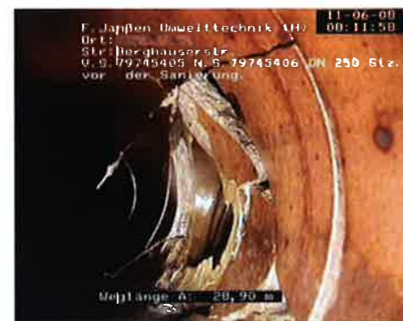
Abbildung 11: schadhafter Anschluss [3]
