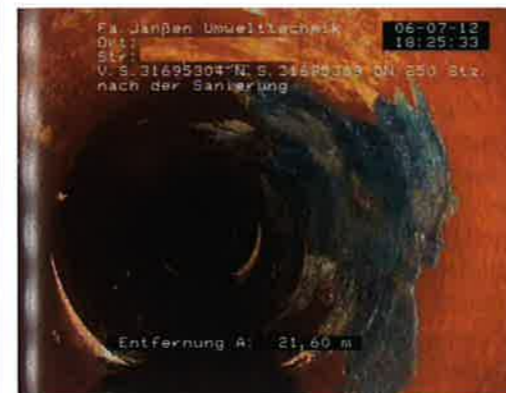
Abbildung 13: nach der Riss- und Scherbensanierung [3]
