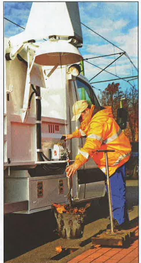
Einsatz in Duisburg: Der Sinkkasteneimer wird maschinell gehoben.
