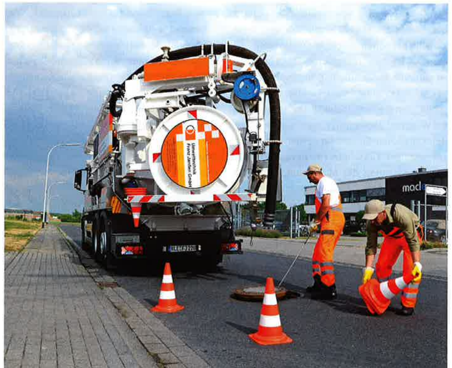
Kanalreinigung mit Sicherheitsschuhen von Elten. | Fotos: Elten GmbH
