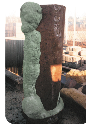
ausgegrabenes Rohr nach der Sanierung
